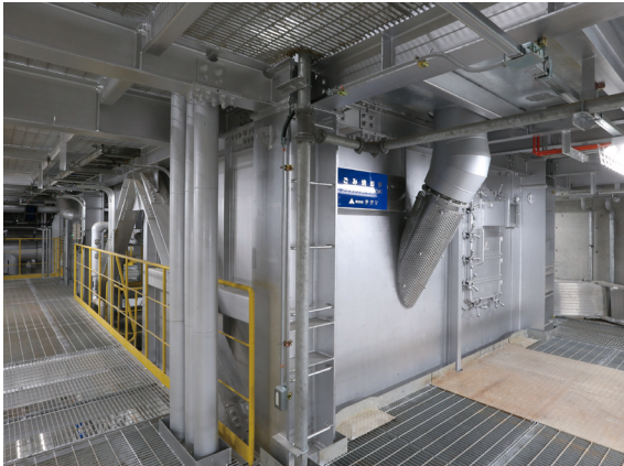
炉内(ストーカ) 焼却炉 様々なごみ質に対応してそれぞれのごみ送り速度と燃焼用空気の吹き込み量を調節することで、850～950℃で焼却を行い、ダイオキシン類の発生を抑制します。
