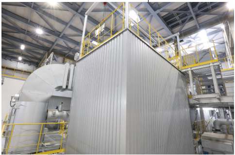
ろ過式集じん機 (バグフィルタ) 消石灰及び活性炭を吹き込んだ排ガスをろ過し、排ガス中に含まれる硫酸化合物、塩化水素、ダイオキシン類等の有害物質を取り除きます。
