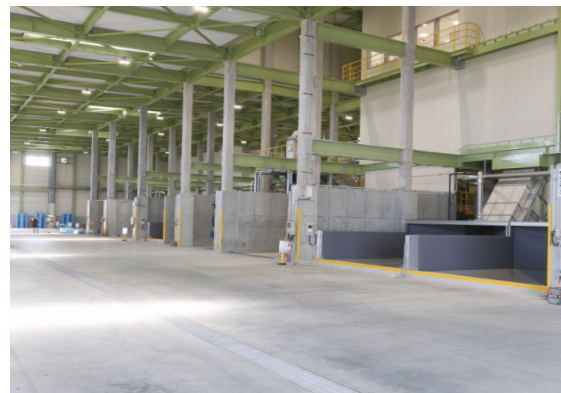
プラットホーム 搬入されたごみをここからそれぞれのラインへ送ります。
